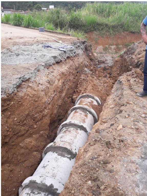
Tubulação REJEITADA (Rejunte pela metade)
